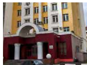
Госнаркоконтроль, г. Нижний Новгород
