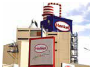
Завод строительных смесей Henkel, Ставропольский край
