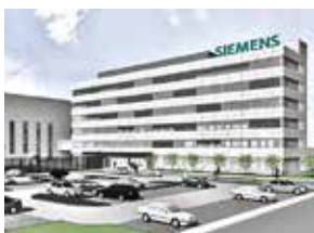
Завод Сименс (газовые турбины), Ленинградская обл.
