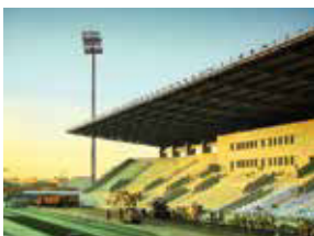
Стадион Труд, г. Подольск
