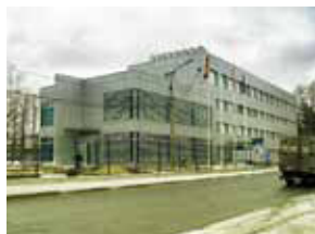
Завод Линде Газ Рус, Калужская обл.
