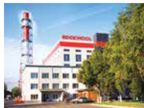
Завод Rockwool, г. Железнодорожный
